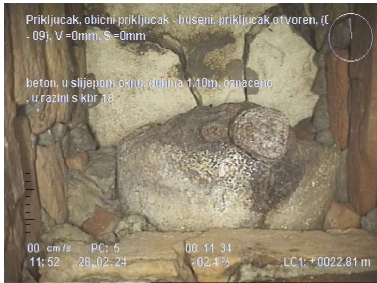
Slika 5. Beton u slijepom oknu kod kbr 18
